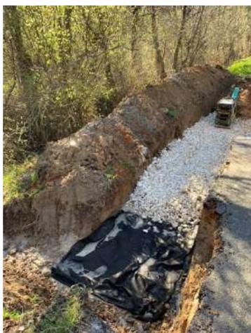
Pour se faire, nous avons réalisé une purge en terrassant sur 1,30m de profondeur avec la pose d'un géotextile sur le fond de la fouille. Par la suite, nous avons mis en œuvre 50 tonnes de calcaire de différentes granulométries et posé un drain de diamètre 300mm. Cette portion de route sera revêtue lors des travaux d'été, en même temps que la rénovation des routes programmées.
