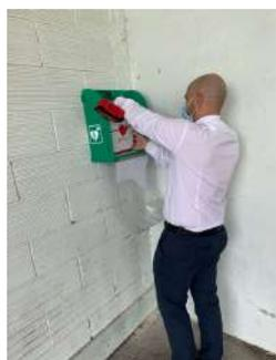
Son installation a été réalisée par des professionnels. Devant être raccordé à l'électricité, Jérémy GUIMAUD, notre électricien, a préparé les branchements électriques qui permet à la caisse contenant le défibrillateur de ne pas subir les températures négatives de l'hiver et ainsi de ne pas altérer son fonctionnement. Un installateur de la société SICLI est venu par la suite installer le défibrillateur.
