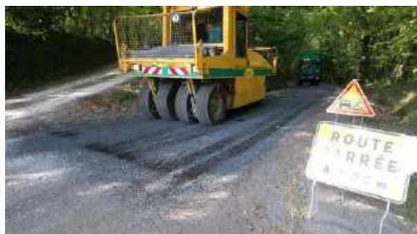
Pour cela il aura fallu réaliser pas moins de 2 225m<sup>2</sup> de rabotage de chaussée, effectuer 2 225m<sup>2</sup> de reprofilage de chaussée suivi de la même surface en imprégnation de support puis 510m<sup>2</sup> de monocouche et 3 822m<sup>2</sup> de bicouche dioritique.
