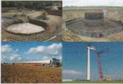
Juste pour le béton : environ 100 camions nécessaires pour chaque éolienne.
