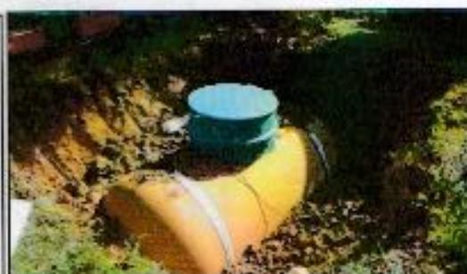
Mise en place de deux nouvelles cuves de gaz, pour un logement et pour la cantine.
