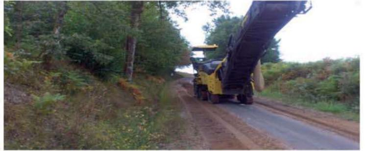
Rabotage et mise en œuvre d'un bicouche sur 3650 m<sup>2</sup> chemin de la Côte d'Or
