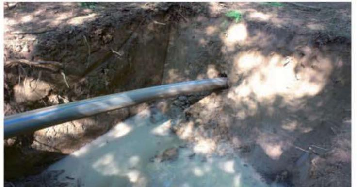
Remplacement de la canalisation d'eau potable entre Bayas et St Martin de Laye par le SIEPA du Libournais avec un fonçage sous le Galostre de 70 m de long dont on voit l'entrée à gauche côté Bayas et la sortie à droite côté St Martin de Laye
